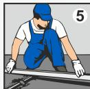
Стяжку БОЛАРС «Высокопрочная Основа» разлейте на поверхности по маякам, установленным параллельно друг другу на расстоянии на 15-20% меньшем длины правила, и распределите широким правилом. Выравнивание поверхности производите за один прием, без перерывов.
