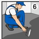
При заливке больших помещений с площадью более 30 м<sup>2</sup> используйте деформационные швы на основе герметиков. Во время заливки и последующие 7 суток температура основания и помещения должна быть не ниже +5°C. Избегайте сквозняков на поверхности пола и в помещении, в ходе работы и последующие 24 часа. В течение 3 первых суток не допускайте попадания солнечных лучей.
